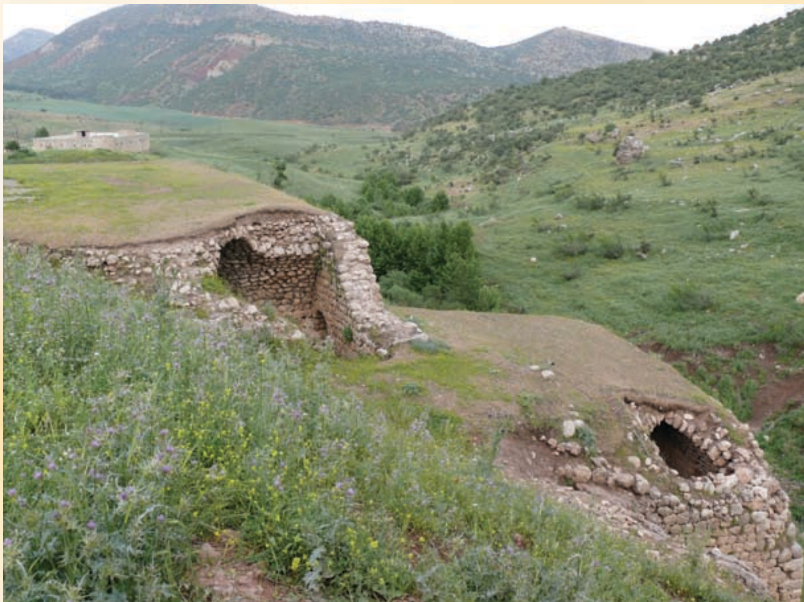
Avayê Xana Êzîd | Здание Хана Эзид | The building of Khana Ezid
